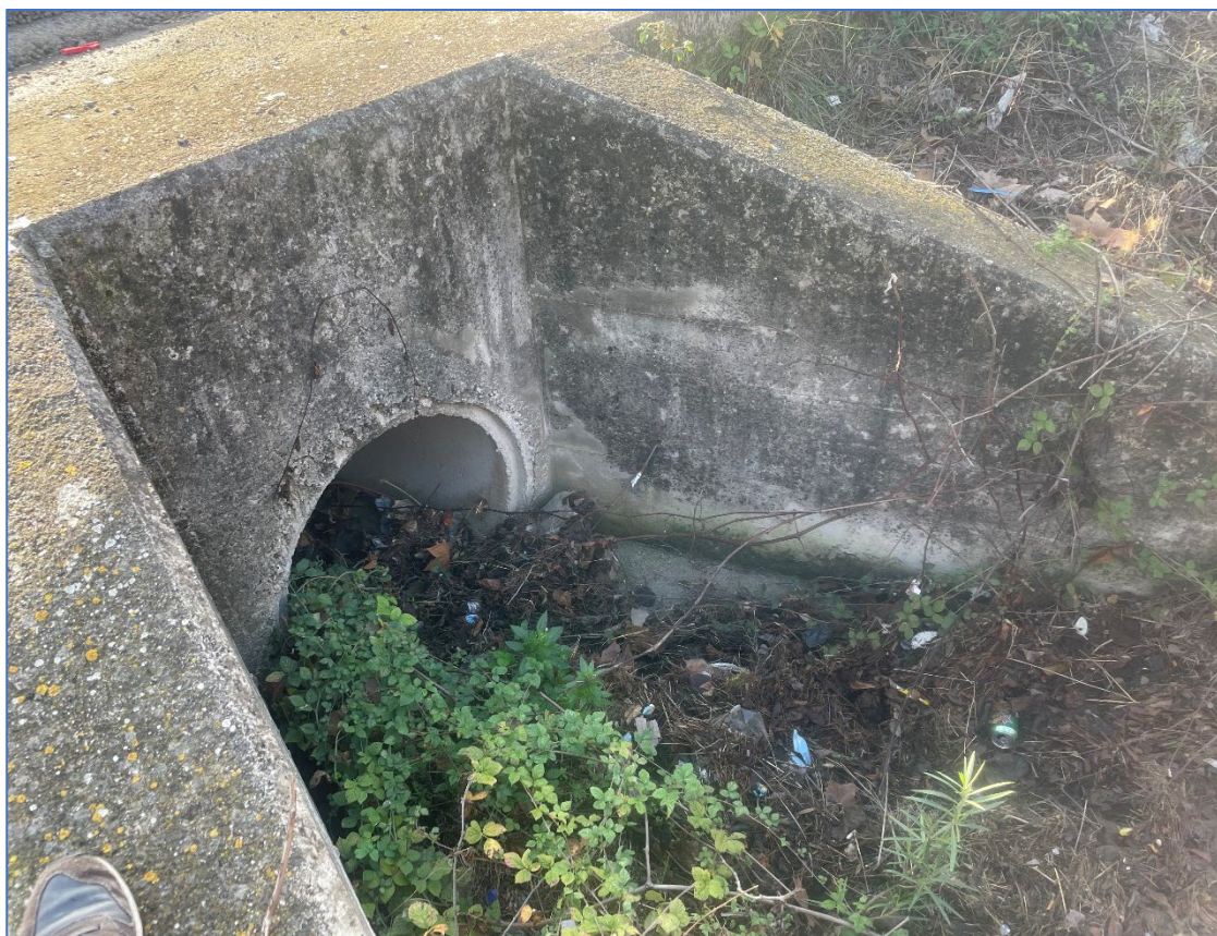
Entrada OD sota carretera C-31
