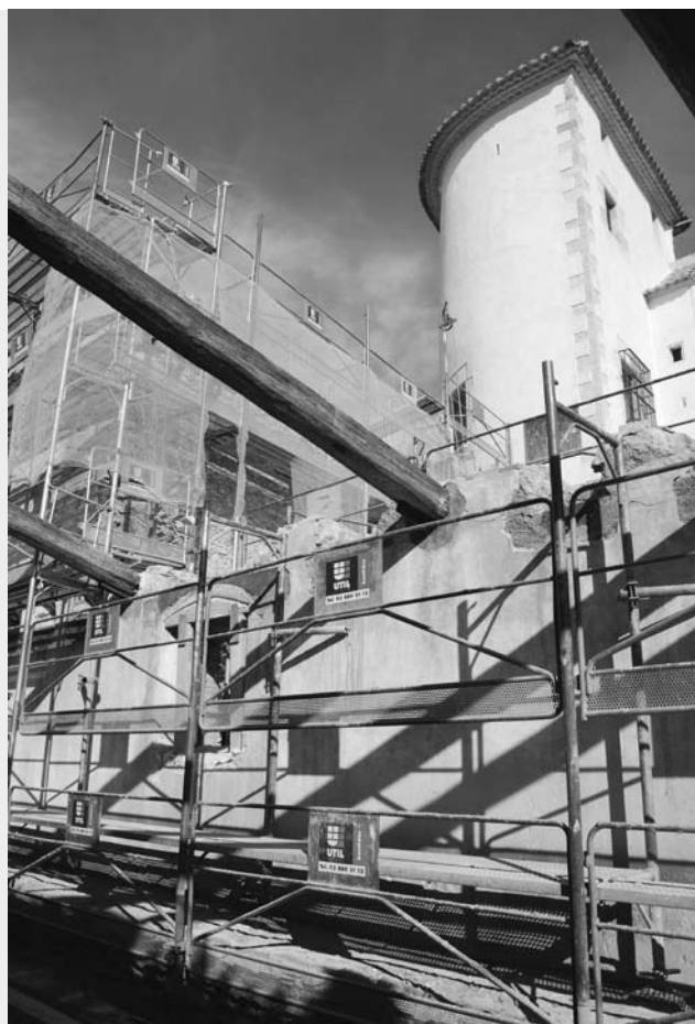
Les obres han deixat les quadres al descobert
