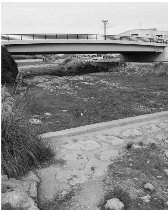
L'actuació afecta al tram entre la C-31 i la via del tren
