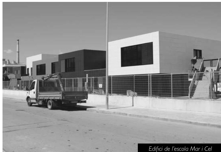
Edifici de l'escola Mar i Cel
